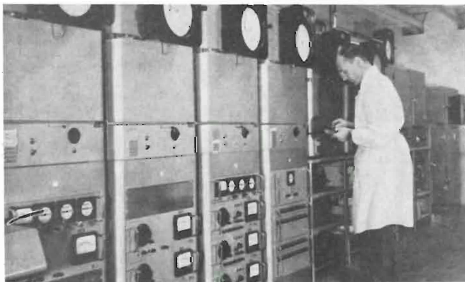
Fig. 2 - Veduta parziale della batteria di stufe per la prova di funzionamento dei semiconduttori a 25 °C o a 55 °C (Usine de St-Egrève); i pezzi sono prelevati e misurati unitariamente dopo 0, 250, 500, 1000 e eventualmente 2000 e 5000 ore di funzionamento.
